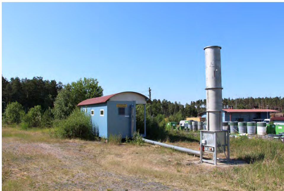
Kuva 3 Uusi toukokuussa 2018 käyttöön otettu soihtupoltin
