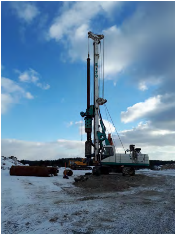
Kuva 2 Uusien kaasunkeräyskaivojen poraamista Korvenmäen kaatopaikka-alueella
