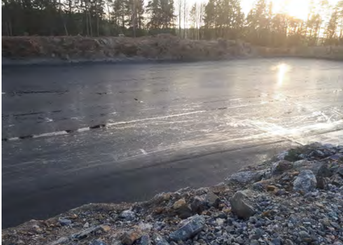
Kuva 3 Kalliovaraston pintarakennetyömaa marraskuussa 2018
